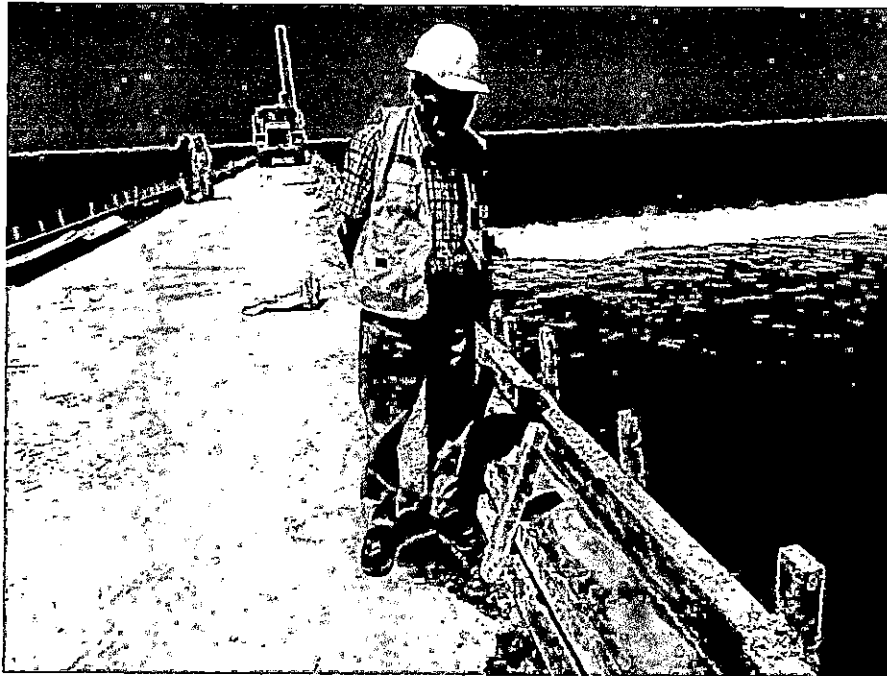
SUPERVISOR VERIFICANDO TRABAJOS
