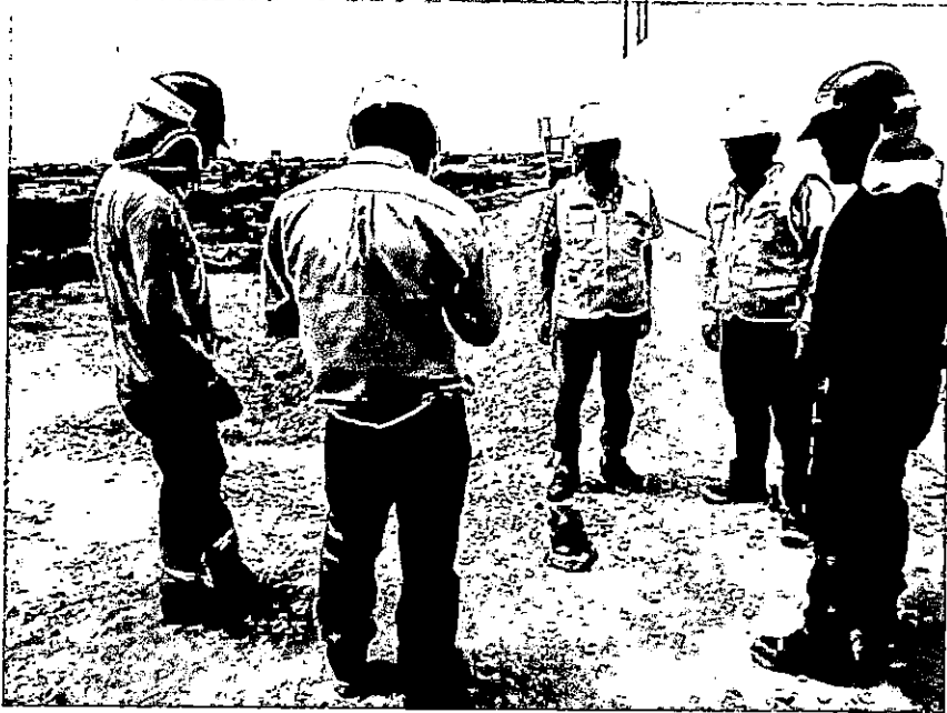
REPLANTEO DE CABLES DEL ADICIONAL N° 10 A PARTIR DE LA SUBESTACION
