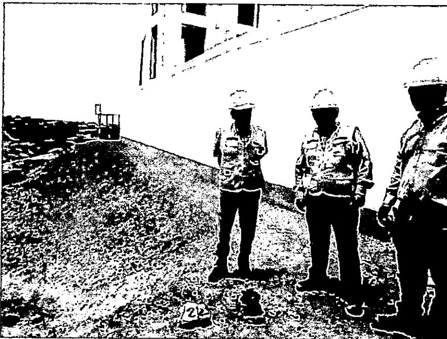
COLOCACION DE HITOS DE REFERENCIA DE LOS PUNTOS INDICADOS EN PLANOS
