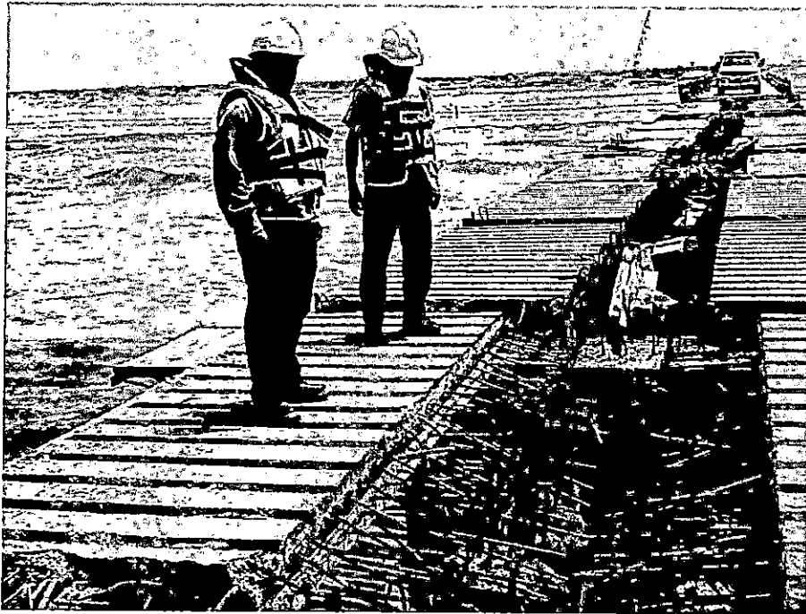
SUPERVISOR Y RESIDENTE EN EJE 174 – 175, SE OBSERVA DESCABEZADO DE PILOTES DE REFORZAMIENTO
