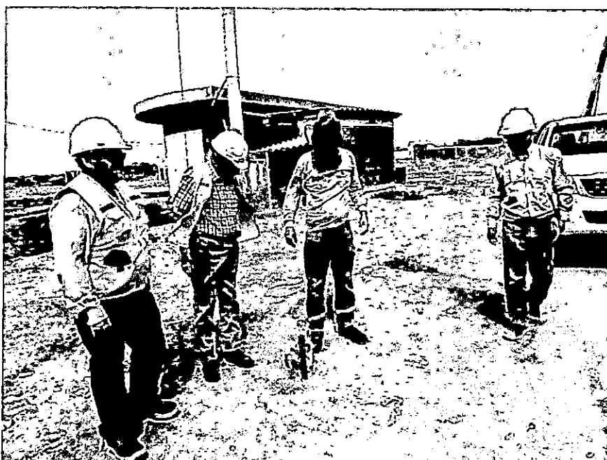
OTRA VISTA DEL REPLANTEO DE CABLES AEROS Y SUBTERRANEOS CORRESPONDIENTES AL ADICIONAL N°.10
