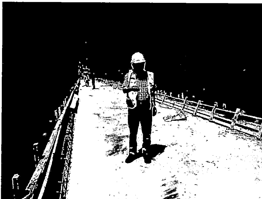
SUPERVISOR EN LOSA DEL MUELLE EJE- 163-164
